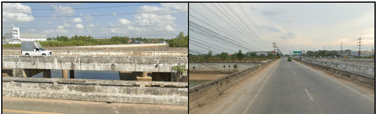
รูปที่ 5-10 สะพานข้ามคลอง ร.1
