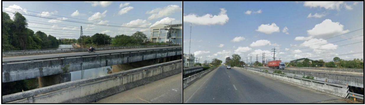
รูปที่ 5-8 สะพานข้ามคลองอุตะเนา
