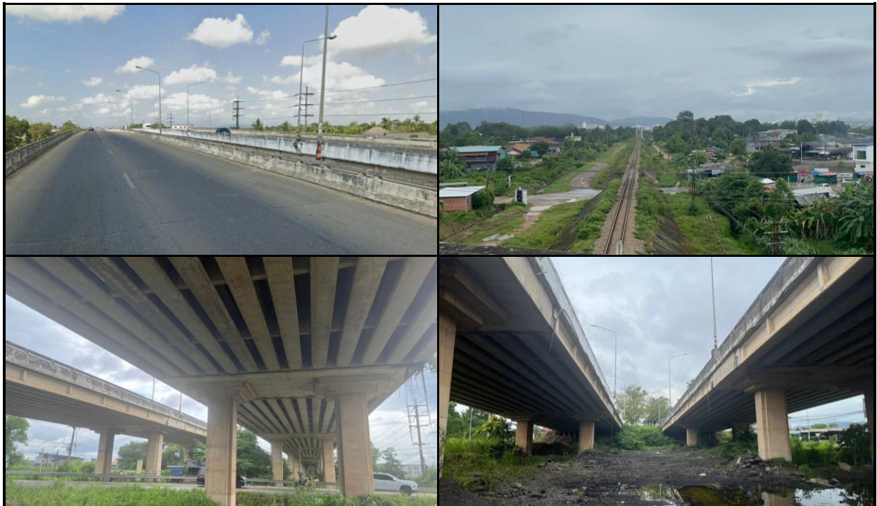
รูปที่ 5-9 สะพานข้ามทางรถไฟ
