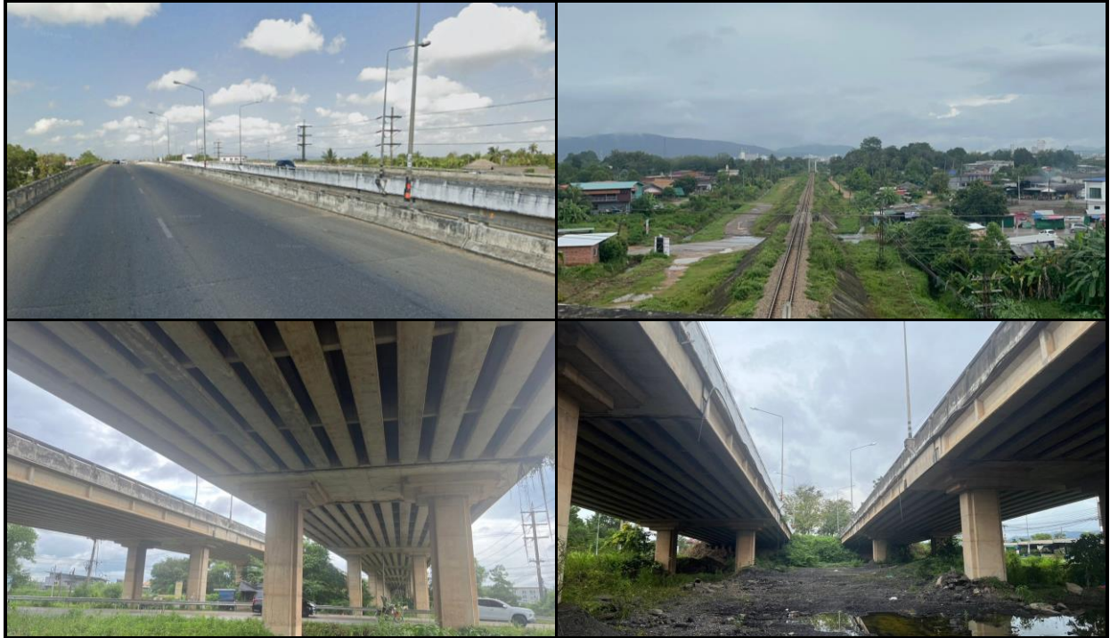
รูปที่ 6.1-9 สะพานข้ามทางรถไฟ
