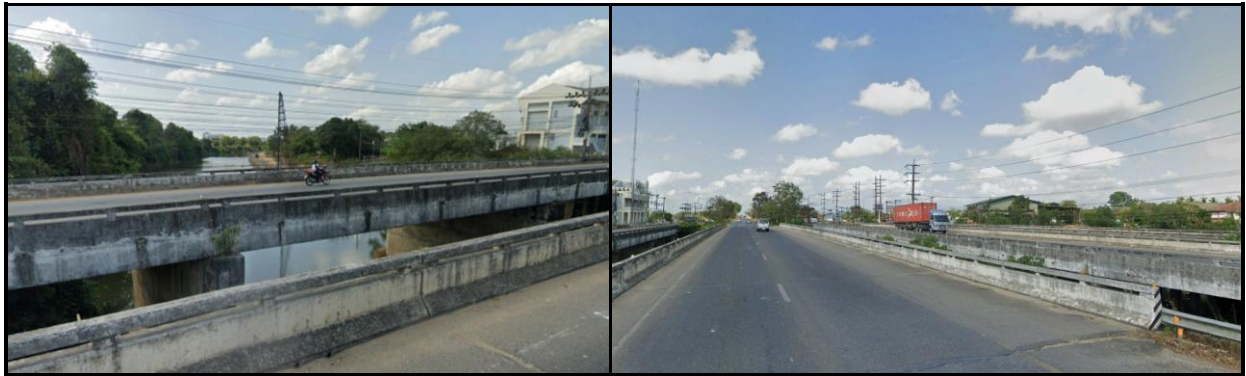
รูปที่ 6.1-8 สะพานข้ามคลองอุตะเกา
